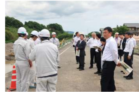
県道安芸物部線道路災害復旧工事
