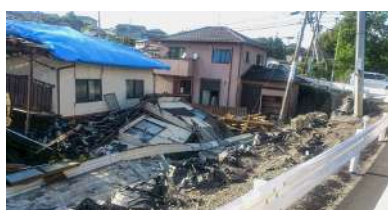
益城町の被災状況
